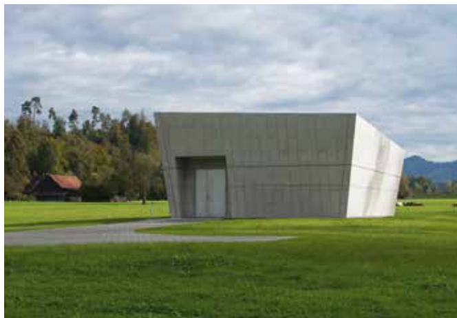
Grundwasserfassung Tägerswil der Wasserversorgung Rapperswil-Jona
